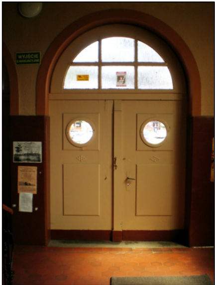
DRZWI DZ1 . Widok drzwi od wew. fot.(1)
