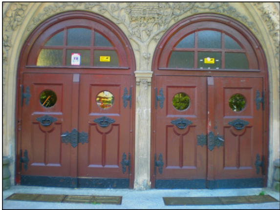
DRZWI DZ1 . Widok drzwi w elewacji. fot.(2)
